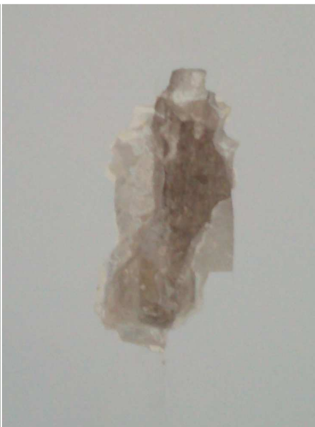
Połączenie segmentu A z segmentem C. Zabetonowana zaprawą cementową dylatacja. Grubość warstwy tynku cementowego do 8 cm.
