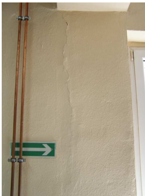
Połączenie segmentu B z segmentem D na parterze. Brak dylatacji w ścianie łączącej segmenty – widoczne samoistne rysy na ścianach – wymuszona dylatacja. Dotyczy to wszystkich ścian na połączeniach segmentów B z A i C na parterze.
