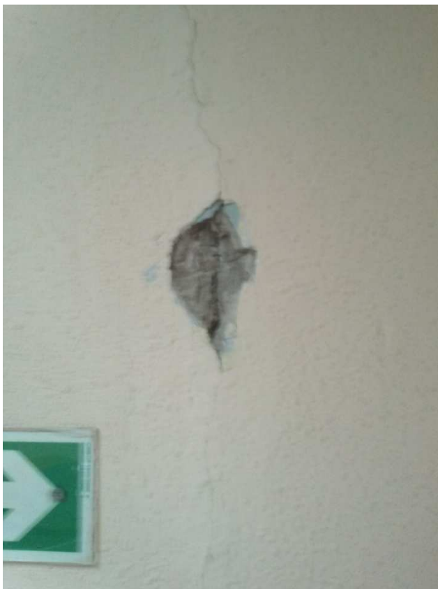
Połączenie segmentu B z segmentem D. Zabetonowana zaprawą cementową dylatacja.
