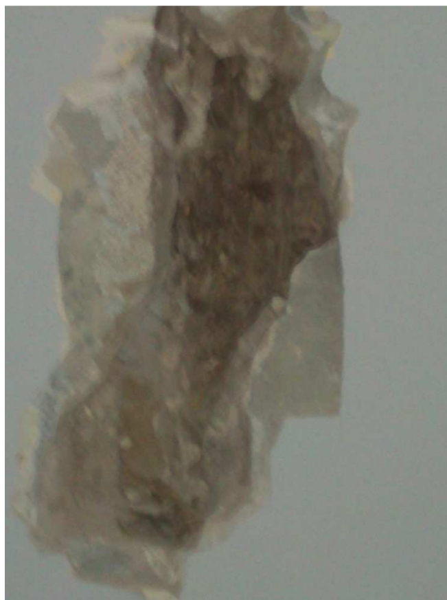
Połączenie segmentu A z segmentem C. Zabetonowana zaprawą cementową dylatacja. Grubość warstwy tynku cementowego do 8 cm.
