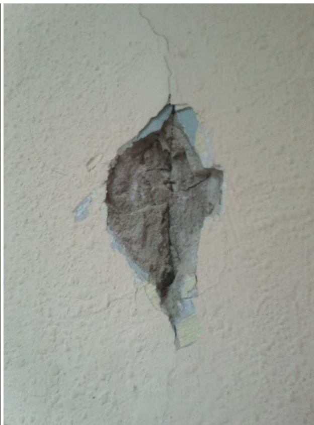
Połączenie segmentu B z segmentem D. Zabetonowana zaprawą cementową dylatacja.
