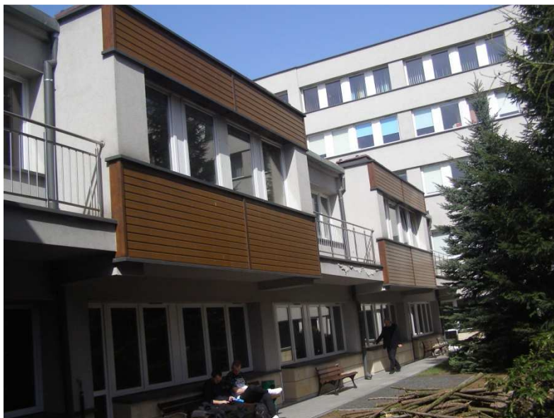
Widok na segment B od strony patio. Elementy zewnętrznej obudowy drewnianej należy poddać impregnacji ogniochronnej.
