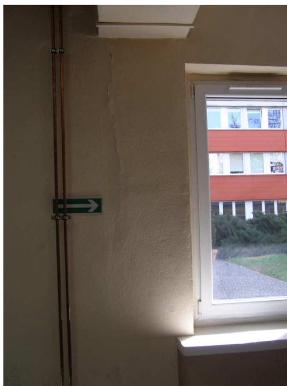
Połączenie segmentu B z segmentem D na parterze. Brak dylatacji w ścianie łączącej segmenty – widoczne samoistne rysy na ścianach – wymuszona dylatacja. Dotyczy to wszystkich ścian na połączeniach segmentów B z A i C na parterze.
